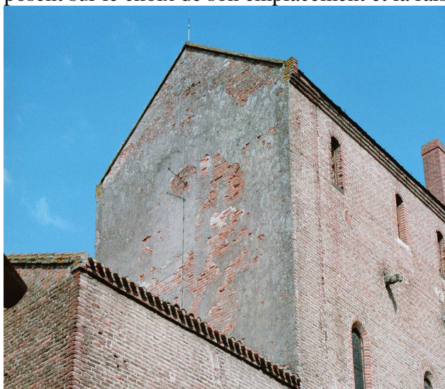
Vestige du cadran de la Berbie avant la mise à jour de la baie gothique
