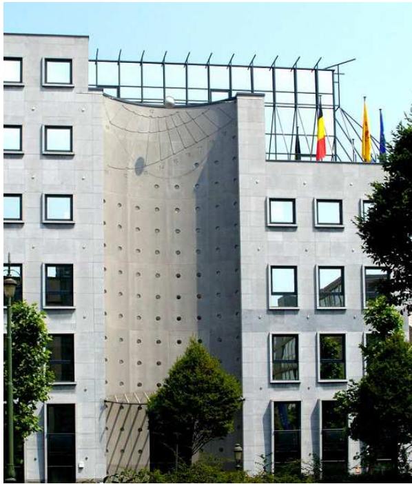
1. Vue générale de la façade de l'immeuble à Bruxelles, Belgique (Photo W. Leenders).
