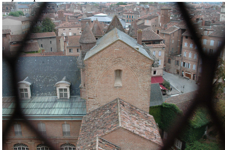
La vue, depuis le chemin de ronde de la tour Saint Michel et dans un deuxième temps, avec celui du clocher de Sainte Cécile était idéale. L'ouverture en partie murée qui a été dégagée en 2001, date des travaux de Durant de Beaucaire XIII e siècle.
